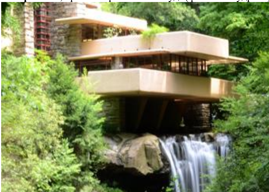
Рис. 3. Резиденція Кауфмана “Будинок над водоспадом” (Fallingwater) – будинок, спроектований у 1935 році відомим американським архітектором Френком Ллойдом Райтом (1867-1959) [29]
